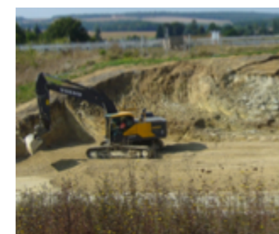
Matériaux du site, traités
