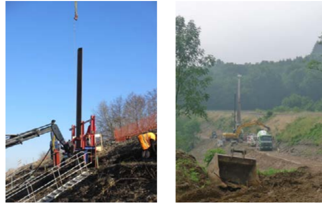
Technique de confortement par clouage vertical
